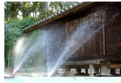
《消火施設(放水銃)の設置》
